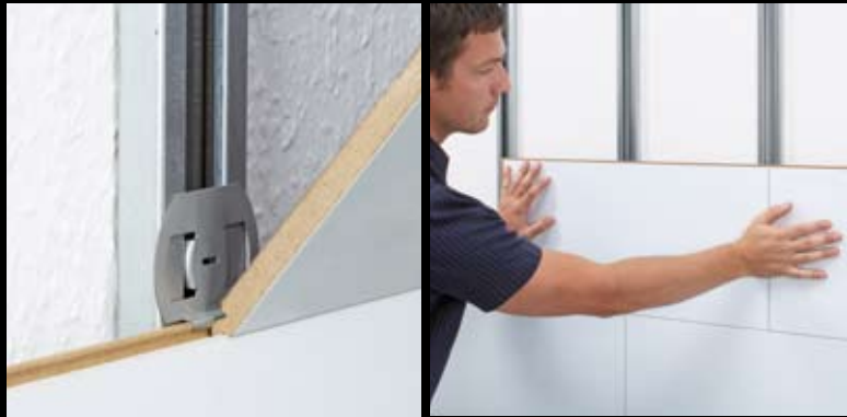
Schritt 5: Das Einsetzen der Folgereihen ist ebenso einfach: Laminatdielen ansetzen, einrasten, fertig.
