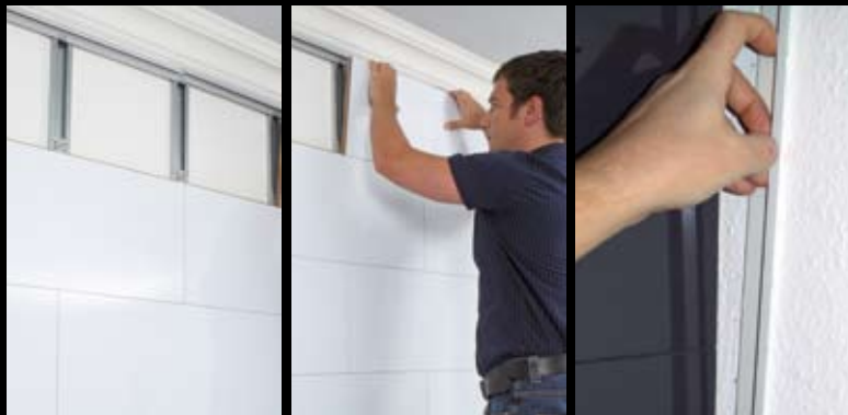
Schritt 6.1: Als Abschluss haben Sie nun mehrere Möglichkeiten. Hier Möglichkeit A mit Schattenfuge und Profilleistenabschluss: Einfach die Profilleisten Nr. 2 um 90 Grad gedreht mit den Montageklammern Nr. 3 befestigen und die Leiste immer ein Stück weiter auf die jeweils neu montierte Diele drücken. Für den sauberen seitlichen Abschluss der Schattenfuge verwenden Sie das Einfassprofil Nr. 8.
