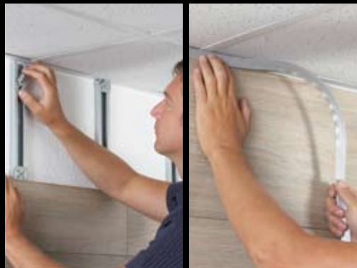
Schritt 6.2: Die zweite Möglichkeit ist ein Abschluss mit dem Abdeckband Nr. 7. Hier werden die Montageclips Nr. 5 eingesetzt und damit jede neue Diele, wie bisher, befestigt. Abschließend setzen Sie das Abdeckband Nr. 7 ein.
